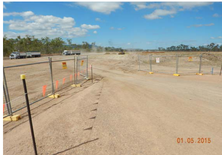
Trucks hauling fill material
