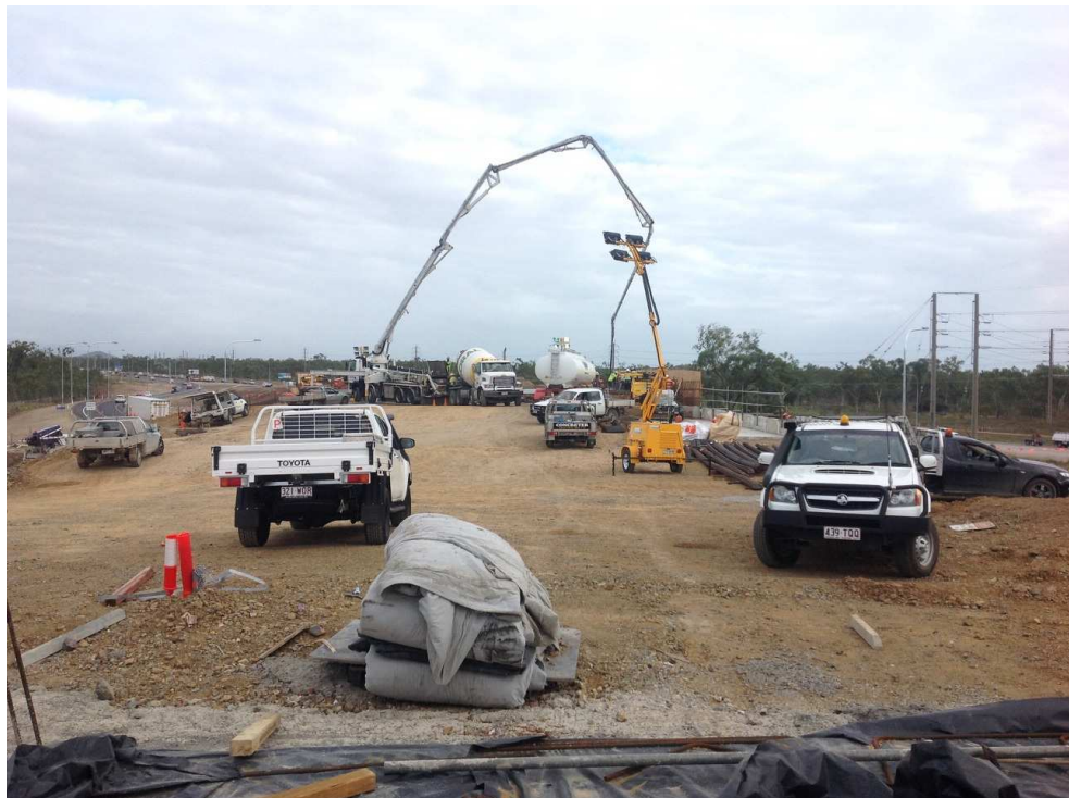
Final Bridge Deck Pour Woolcock St Overpass
